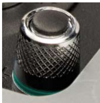
Tilkobling for elektrisk jording av elementene.
